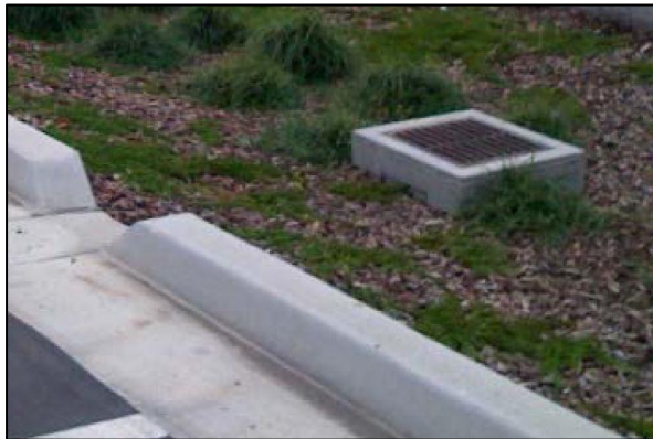
Obr. 1 – Příklad provedení tzv. suché vpusti
